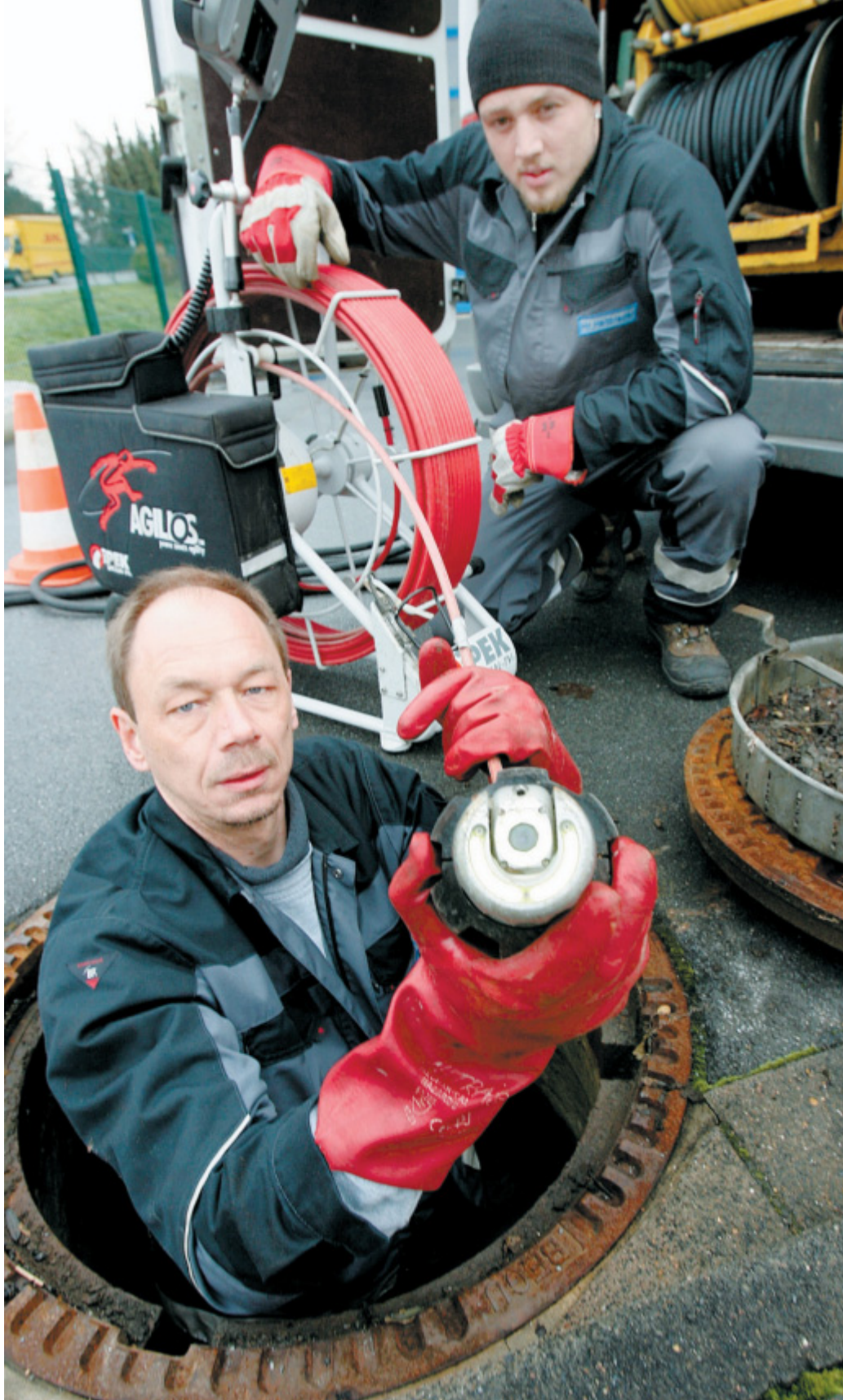
Elektronisches Auge: Oliver Niemann (vorne) und Jens Heitbreder demonstrieren in Herford, wie sie mit einer Spezialkamera die Abwasserkanäle untersuchen. FOTO: FRANK-MICHAEL KIEL-STEINKAMP
